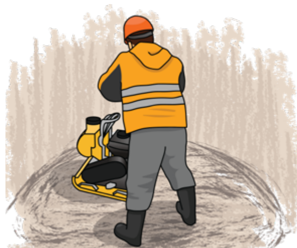
Рисунок: Выравнивание песчаного основания
