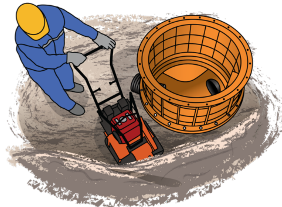
Рисунок: Механическая трамбовка грунта
