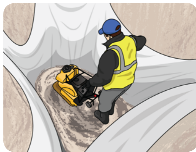
Рисунок: Выравнивание песчаного основания с геотекстилем
